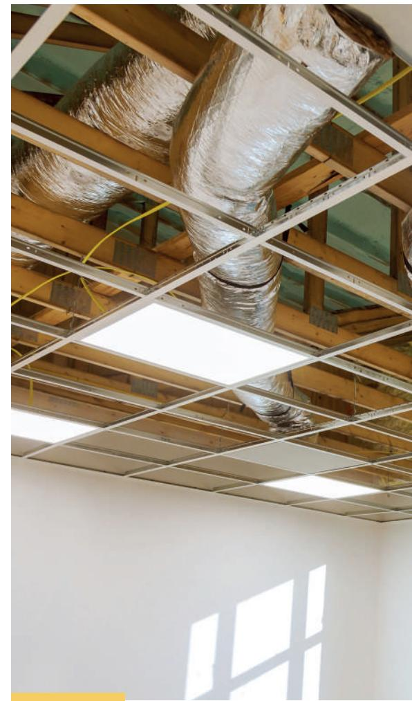
12. Ventilation mécanique contrôlée double flux et centrales de traitement d'air à débit constant ou variable.
